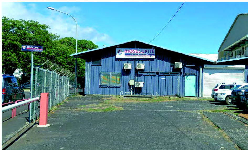
► Le bâtiment de la cellule zoosanitaire sur le terrain de l'aéroport de Faa'a
