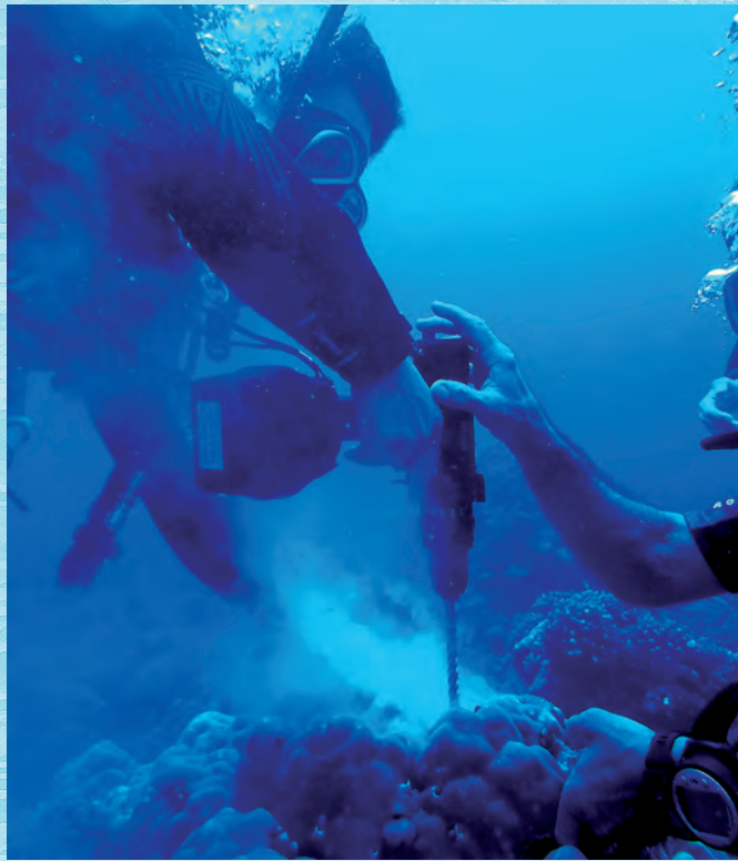
Sur un chantier de travaux sous-marins
